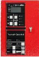
Feuerwehr-Informations- und Bediensystem mit integriertem FAT 4000, FBF 4000 und ADP4000, sowie Steckfächern für Feuerwehr-Laufkarten im zweitürigen, abschließbaren Gehäuse aus robustem Stahlblech.
